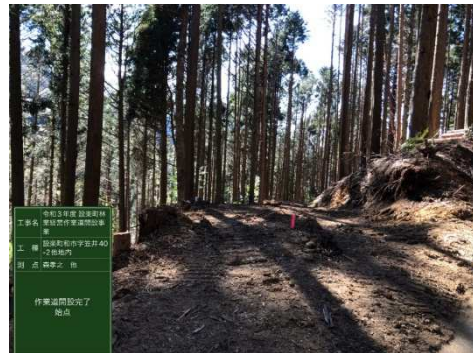
現場写真（作業道開設後：笠井①線）
