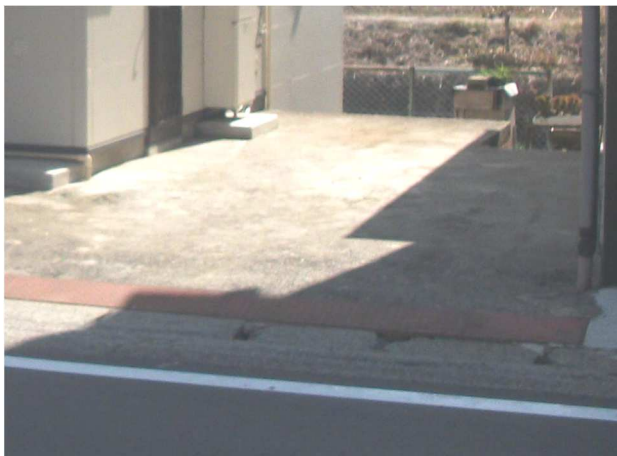
野向農林業担い手支援住宅駐車場修繕工事
