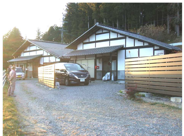
町営杉平南住宅外部木部塗装工事
