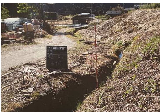
かんがい排水工事 (津具) (着手前)
