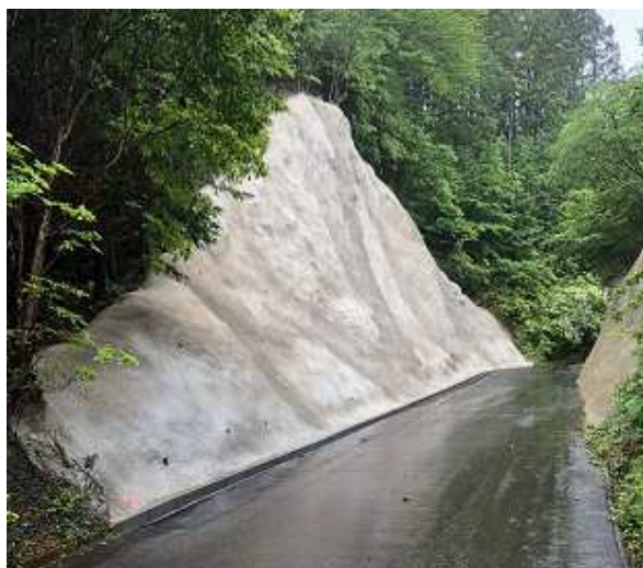
林道鹿ノ子線 モルタル吹付
