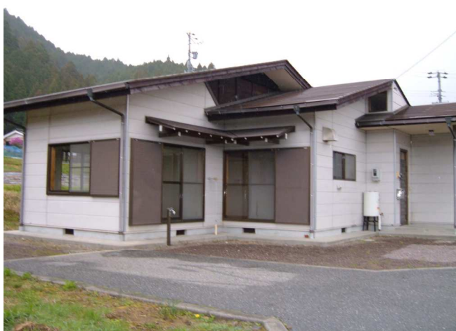
平山住宅1号修繕工事
