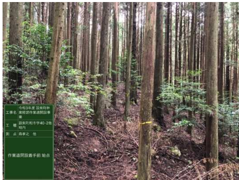
現場写真（作業道開設前：笠井①線）
