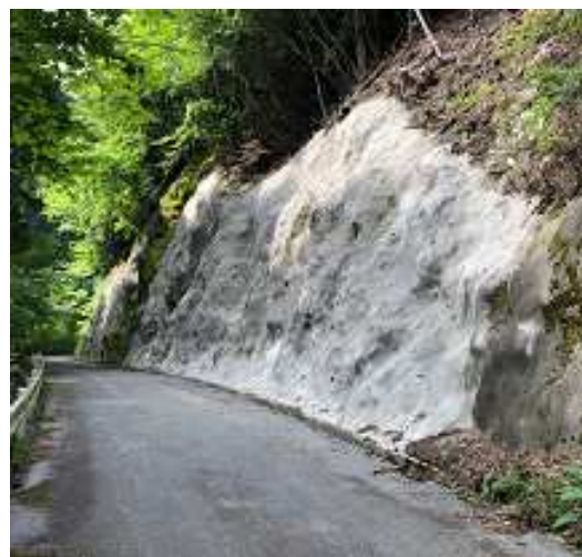
林道田内野平線 モルタル吹付
