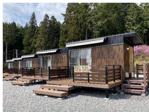
面ノ木公園多目的施設
